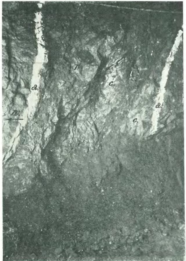
Photo Nr. 6. — Der Mittelsprung im Tunnel Esch-Rümelingen. Der Sprung setzt in der Mitte des 2 km langen Tunnels durch. a. - a' = Begrenzungsflächen der Verwerfung mit Rutschstreifen, dazwischen stark zerbrochenes Gestein, durchsetzt mit sekundärem Calcit (c.) und Pyrit (p.). — Zur Erhöhung des Kontrastes wurden die Rutschflächen a und a' aufgehellt. (Zu p. 111). — W = Westrichtung.
