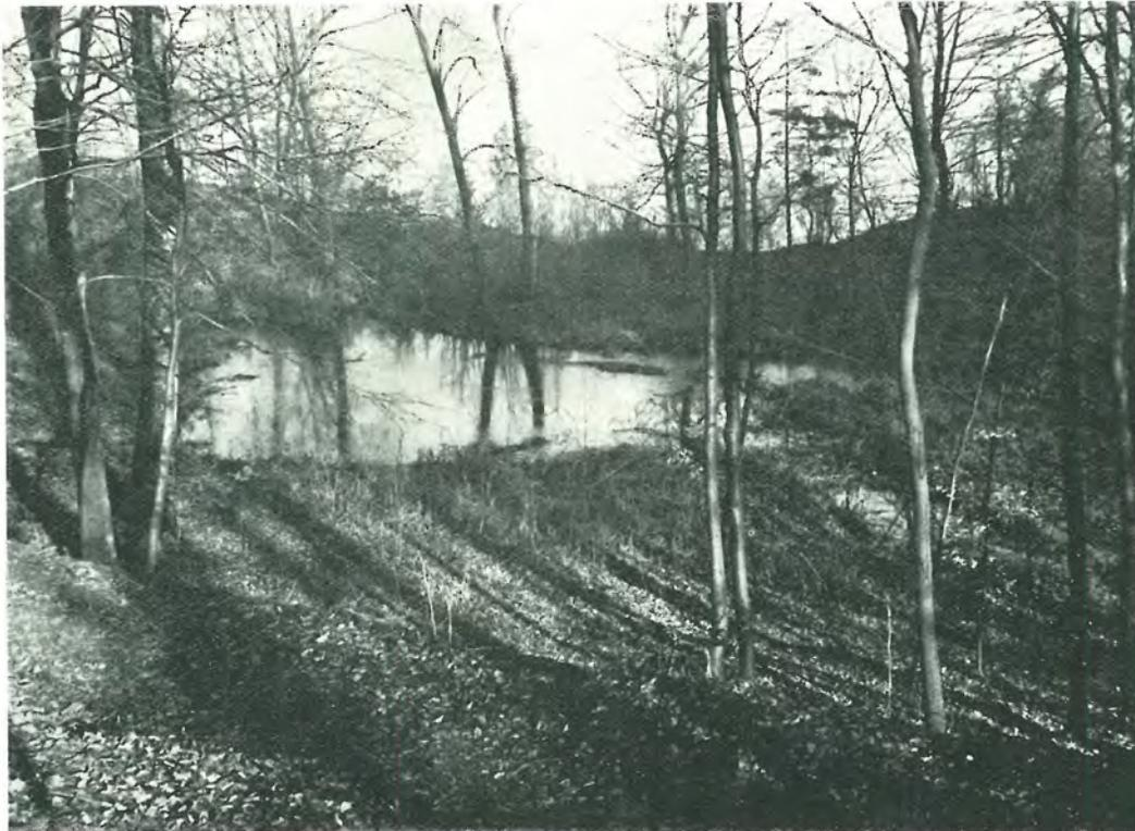
Photo Nr. 4. — Durch den Stollenabbau verursachte Einbruchstrichter im Glimmermergel am Nordrande des Titelberg. Da durch den Einbruch der Wasserhorizont über dem Glimmermergel angerissen wird, ist die Vertiefung ständig mit Wasser angefüllt. (Zu p. 7.)
