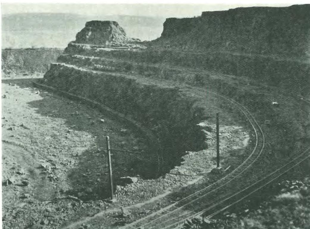
Photo Nr. 10. — Tagebau Mühlenberg (Tetingen). Stufe über dem 1. Gleise: (graues) Lg. 1 und (gelbe) Lg. 2 u. 2a; Stufe über dem 2. Gleise: Zwischenmittel unter dem (roten Haupt-) Lg. 3; Stufe über dem 3. Gleis: (Rotes Haupt-) Lg. 3. Oberste Stufe: Ob. kalk. Lagergruppe, in der Lücke abgebaggert. (Zu p. 169.)
