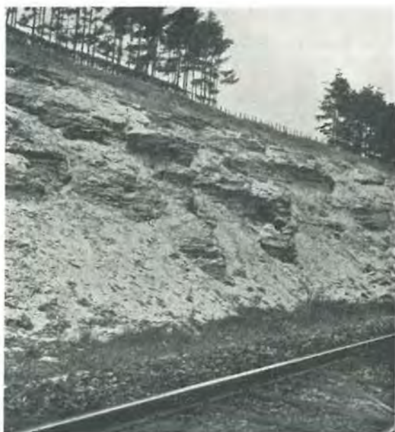
Fig. 2. Schiste bitumineux dans une tranchée entre les stations de Bascharage et de Schouweiler (km. 4.692-5.525) (Phot. Neubronner)
