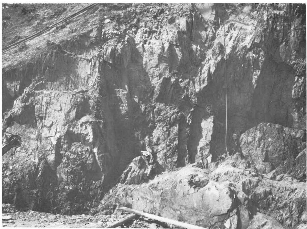
Photo 3. Aushub für die Fundierung der Mauer am rechten Talhang. In der Mitte des Bildes von rechts oben nach links unten verlaufend, die Verwerfung c .
