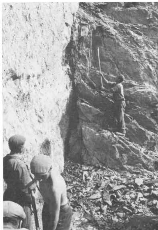
Photo 7. Verwerfung d am linken Talhang.
