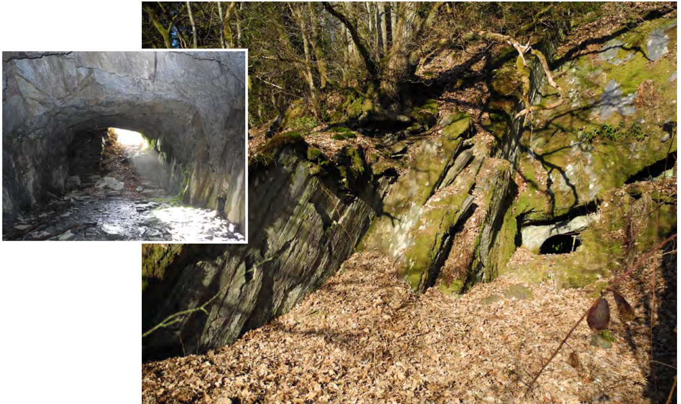
Photo 2 : Entrée d'une galerie de l'ancienne ardoisière située au SW de Niederwampach-Schimpach. Point W449. La photo encadrée dans le coin supérieur gauche montre l'entrée de cette galerie vue de l'intérieur.
